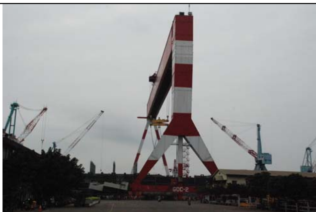
台船大型吊車
