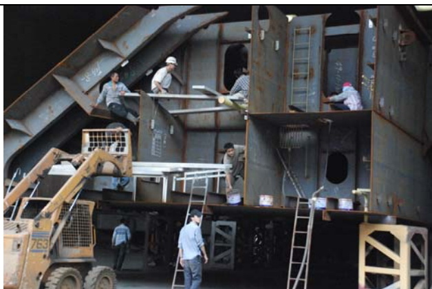
準備架設施工未噴砂的 BLOCK
