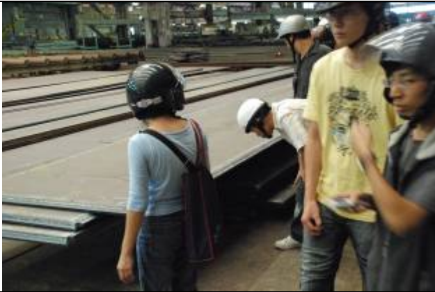
厚達 6cm 的高張力鋼板邊緣開槽
