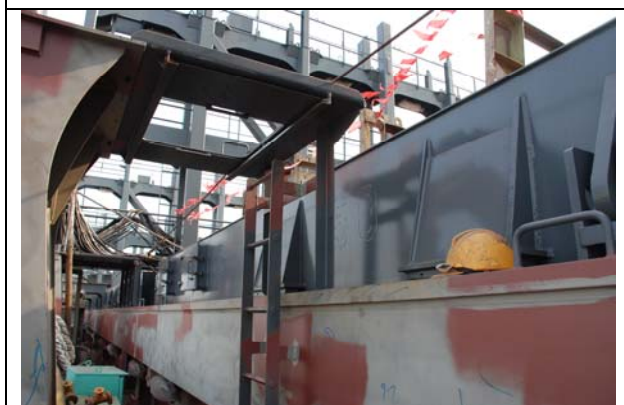
施工中狹長的走道
