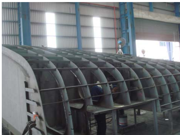
船段結構組合，尚未蓋板前。
