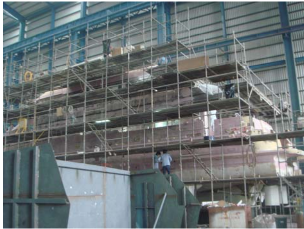
施工建造中的 JY108 (jade95') 之系列型號。
