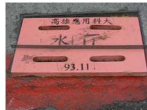
水 11 第五次檢查-正面 (11.30) 環氧樹脂砂漿+玻璃纖維布溝蓋 (大)
