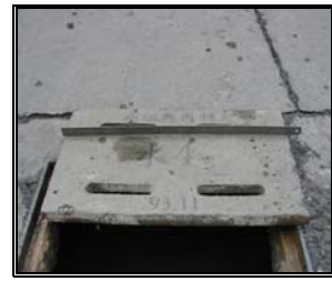
水 4 第五次檢查-正面 (11.30) 高性能水泥砂漿溝蓋 (小)
