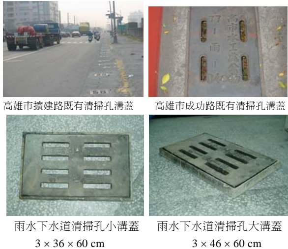
圖 2 高雄市雨水下水道清掃孔溝蓋尺寸 [2]
