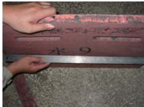
水 9 第六次檢查-正面 (12.16) 樹脂複合材料+玻璃纖維布溝蓋 (大)
