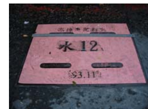
水 12 第五次檢查-正面 (11.30) 環氧樹脂砂漿+玻璃纖維布溝蓋 (大)
