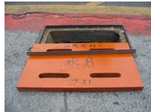
水 6 第五次檢查-正面 (11.30) 電木板溝蓋 (小)
