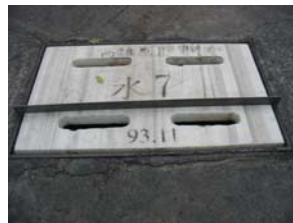
水 7 第五次檢查-正面 (11.30) 塑鋼溝蓋 (小)
