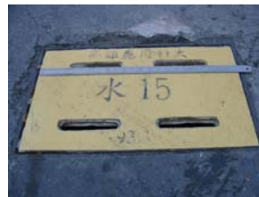
水 15 第五次檢查-正面 (11.30) 環氧樹脂砂漿+玻璃纖維板溝蓋 (小)
