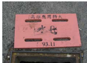
水 8 第五次檢查-正面 (11.30) 樹脂複合材料+玻璃纖維布溝蓋 (小)
