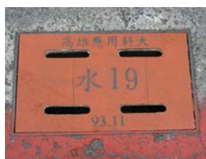
水 19 第五次檢查-正面 (11.30) 高性能水泥砂漿+電木板溝蓋 (小)
