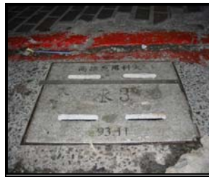
水 3 第五次檢查-正面 (11.30) 高性能水泥砂漿溝蓋 (大)
