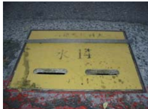
水 14 第五次檢查-正面 (11.30) 環氧樹脂砂漿+玻璃纖維板溝蓋 (大)
