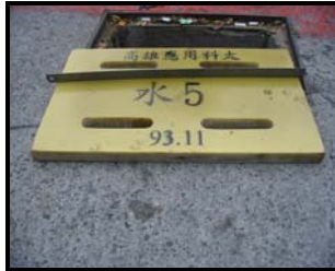
水 5 第五次檢查-正面 (11.30) 玻璃纖維板溝蓋 (小)
