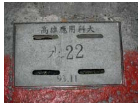
水 22 第二次檢查-正面 (11.20) 高性能水泥砂漿+塑鋼板溝蓋 (小)
