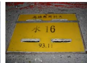
水 16 第五次檢查-正面 (11.30) 高性能水泥砂漿+玻璃纖維板溝蓋 (大)
