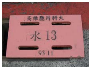
水 13 第五次檢查-正面 (11.30) 高性能水泥砂漿+玻璃纖維布溝蓋 (小)
