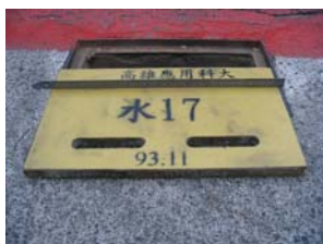
水 17 第五次檢查-正面 (11.30) 高性能水泥砂漿+玻璃纖維板溝蓋 (小)
