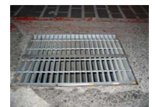
水 24 鍍鋅格柵板第五次檢查 (11.30) 鍍鋅格柵板溝蓋 (大)
