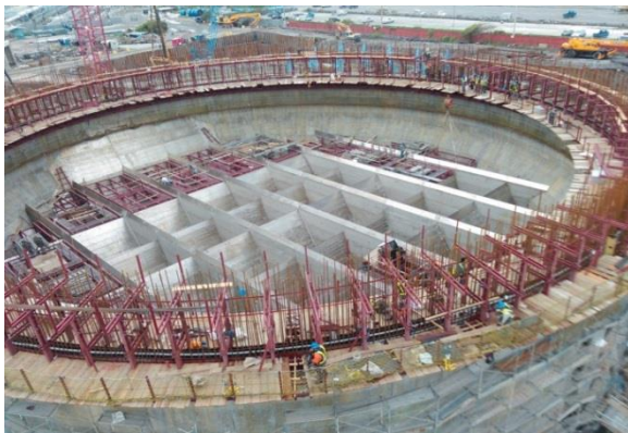
圖 3-2 滑動模板組裝情形
