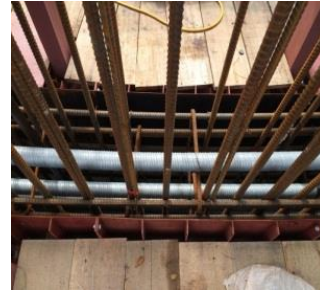
圖 3-15 預力套管防水膠布施作
