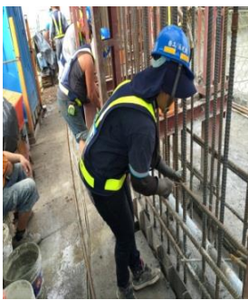
圖 3-13 鋼筋綁紮情形
