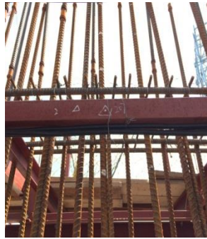
圖 3-12 鋼筋高程及間距標示
