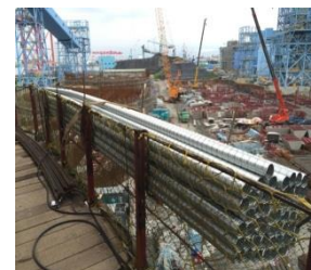
圖 3-10 預力套管管架
