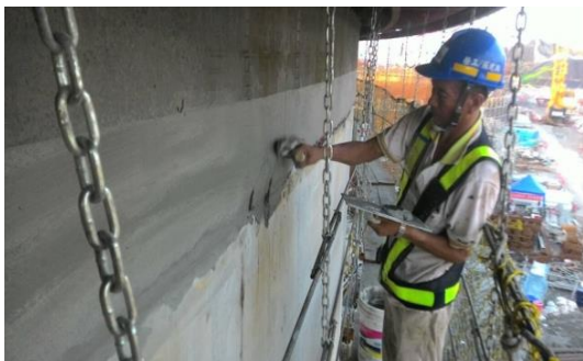
圖 3-20 牆面粉光情形
