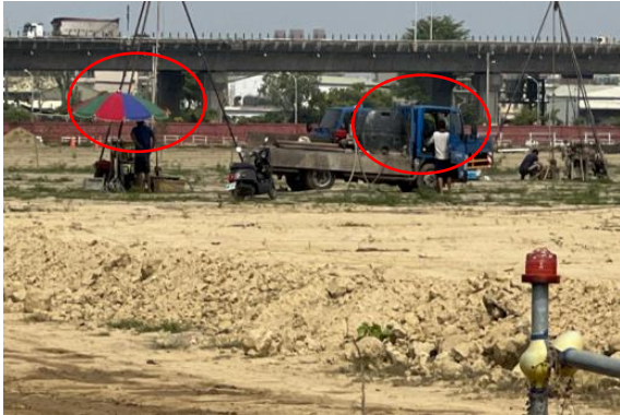
圖 9 門禁管制設置現況
