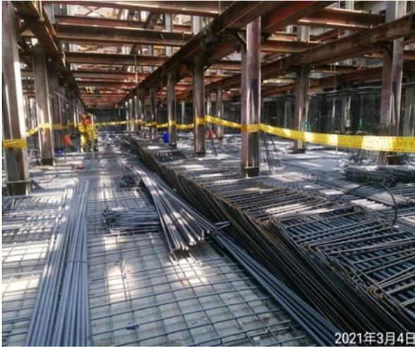
圖 8. 現場地梁鋼筋倒塌-1
