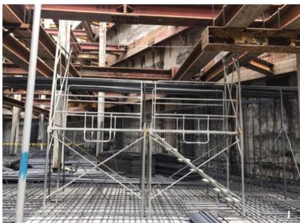
圖 15. 地梁鋼筋組立上層筋施工工作平台
